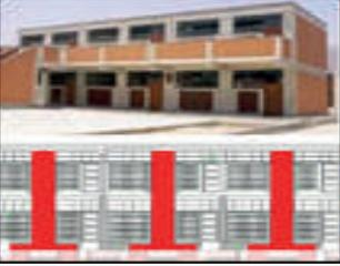
**2.- Concreto armado (tipo APORTICADO):** Estructura de Concreto Armado formado por las columnas y vigas robustas que forman pórticos.
