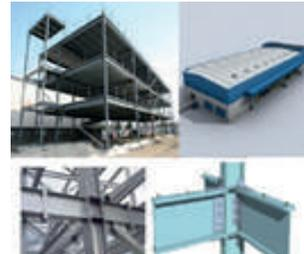
**7.- Módulo Prefabricado PRONIED:** Sistema prefabricado, con una plataforma y estructura de acero, muros de paneles metálicos y cobertura ligera.
